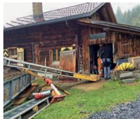
Während dem Umbau
