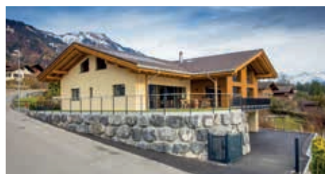
Neubau EFH Brienz
