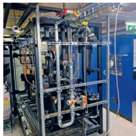
Coop Meiringen – Einbau Zwischenkreise Wärmerückgewinnung
