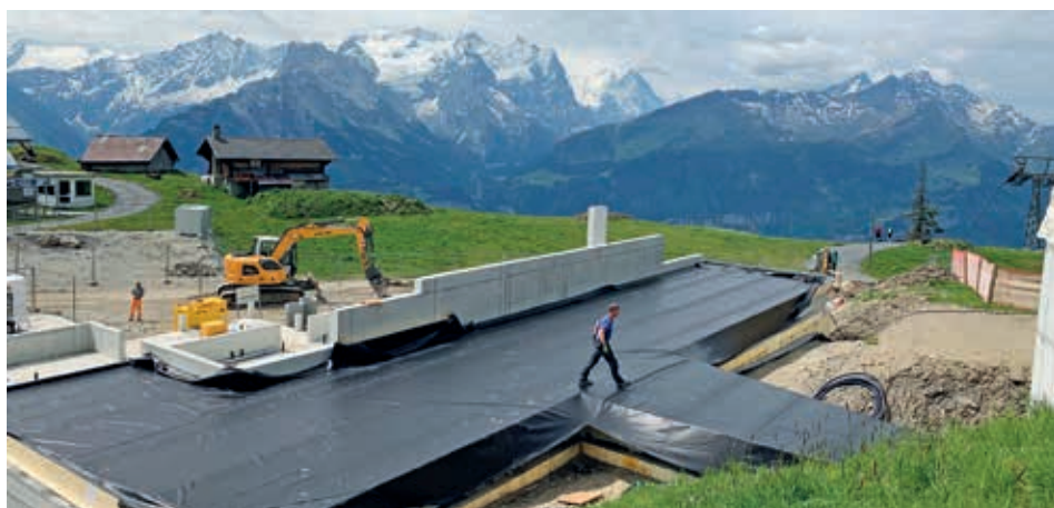
Berghaus Käserstatt – Abdichtung Flachdach
